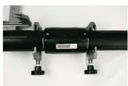
Fase 5 posizionamento ed allineamento
