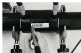
Fase 6: Ajuste de los parámetros de soldadura del estilo-gráfica
