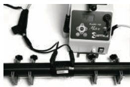
Fase 7: Soldadura y refrigeración
