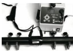
Fase 7 saldatura e raffreddamento
