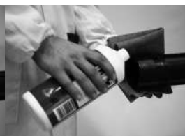
Fase 4 pulizia degli elementi da saldare
