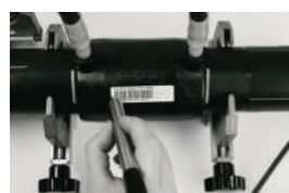
Fase 6 impostazione dei parametri di saldatura con penna ottica
