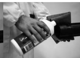
Fase 4: Limpieza de los elementos de soldadura
