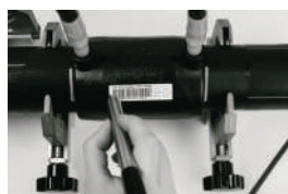
Phase 6 réglage des paramètres de soudure avec crayon optique
