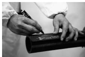
Fase 2: Identificación de la zona de rascadura
