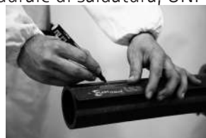
Fase 2 identificazione della zona di raschiatura
