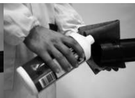
Phase 4 nettoyage des éléments à souder
